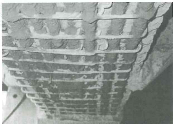
写真5 防錆材塗布後の状況
