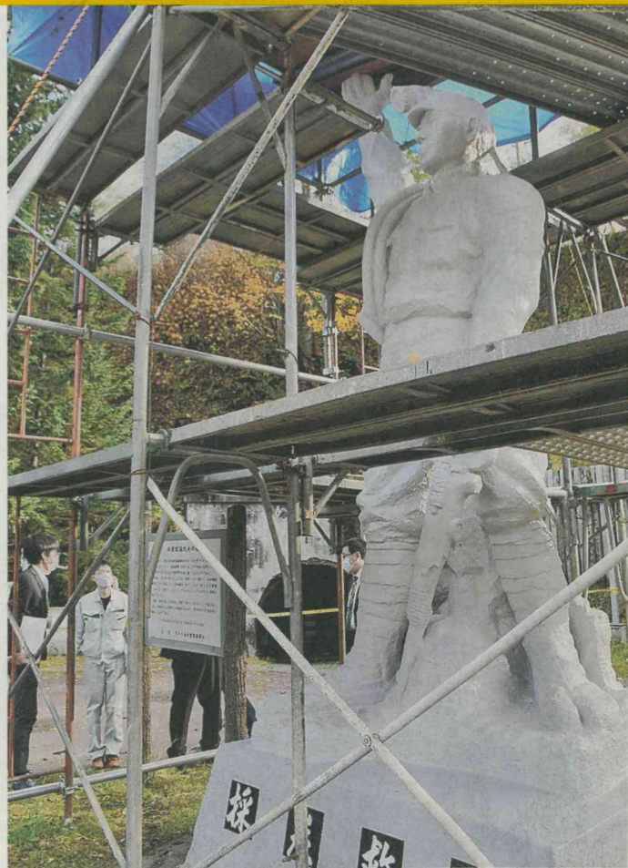
修復が完了した採炭救国坑夫の像。積雪に備え、足場は来春まで残す
