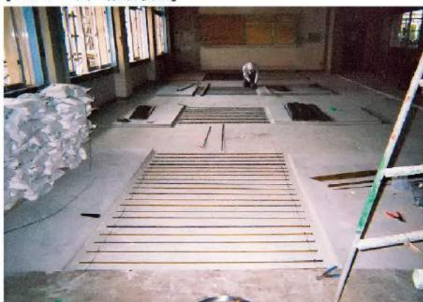
【スラブ上面の配筋状況】
