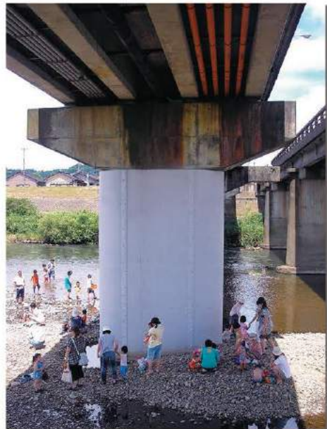
【鋼板巻立ての防錆塗装】
