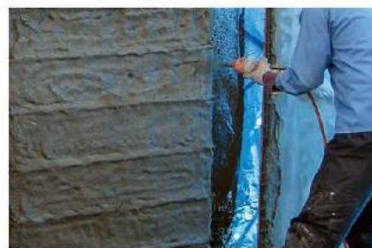
吹付け作業 タイプⅡ
