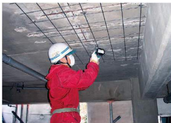
スラブ下面への補強筋配置
