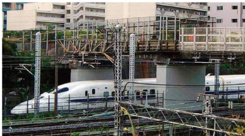
【建築限界の厳しい施工例】
