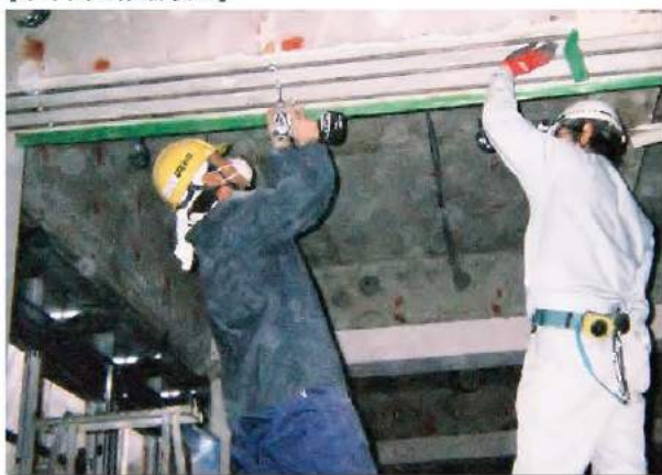
【梁下面の配筋状況】
