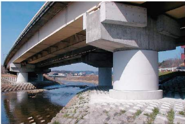
【鋼板巻立ての防錆塗装】
