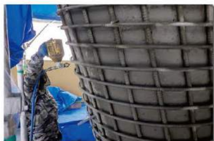
吹付け作業 タイプⅠ
