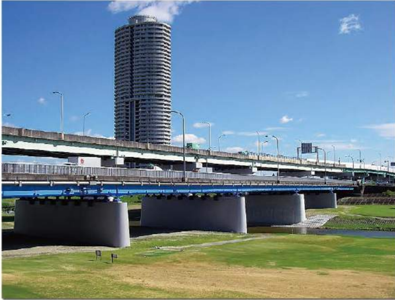
【河積阻害率の制約下での施工例】
