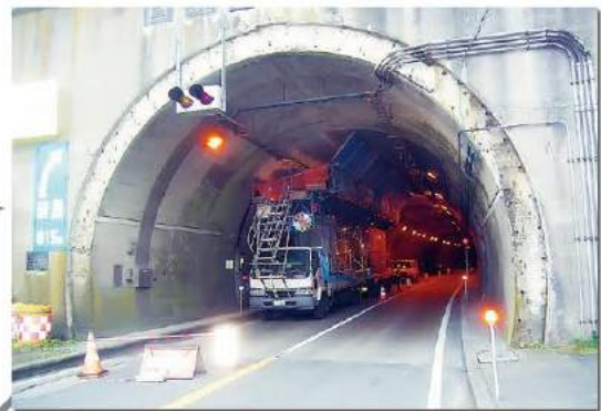
施工中(足場状況)
