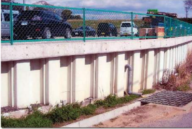
【鋼矢板の防錆】
