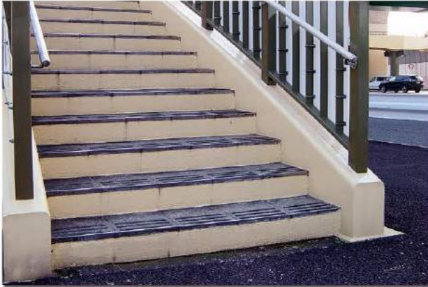
【鋼製歩道橋の蹴上げ部の防錆(トップ塗装あり)】
