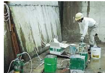
VSシステムによる注入施工中
