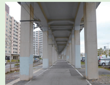
写真2 海岸に近い高架橋の橋脚
