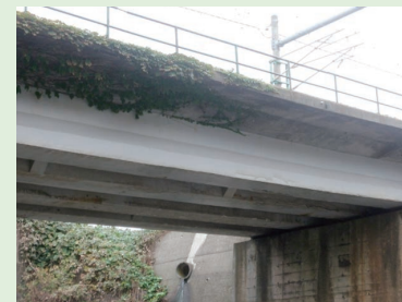
写真1 海岸沿いの橋梁の桁
